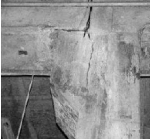
図1 建屋構造の劣化
