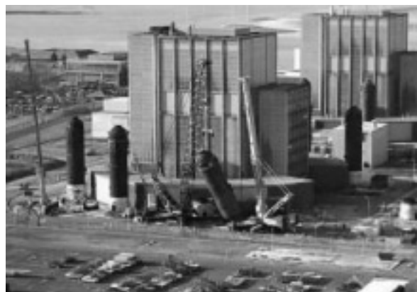
図2 熱交換器の取り外し横置き作業
