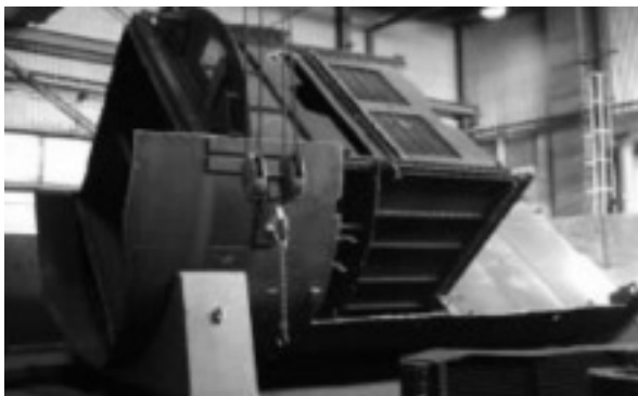
図5 処理設備内で熱交換器の切断解体
