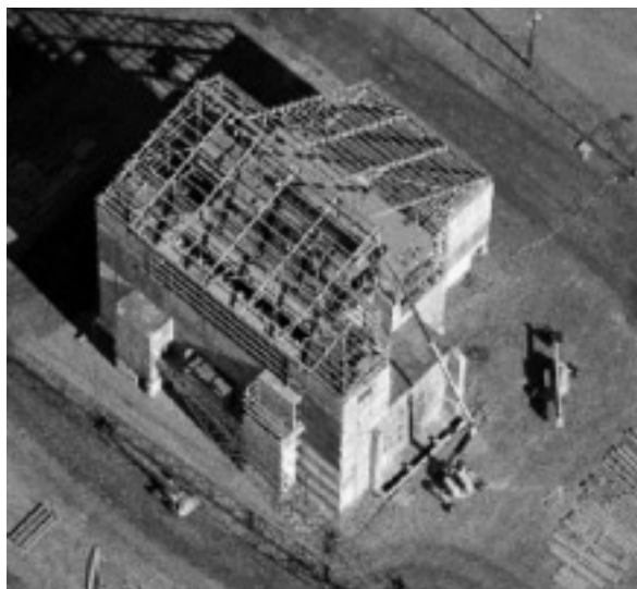
図4 H原子炉SSE（建設中の様子）
